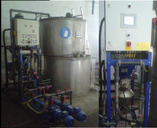
Planta de preparación de Poli por lotes EDAR Figueres
