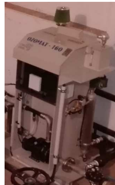
Oxidación agua terciario EDAR Sta. Cristina
