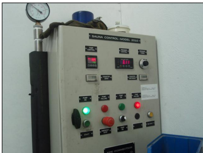
Imagen 4. Parámetros de sauna. 3 bar de presión a 70° C.
